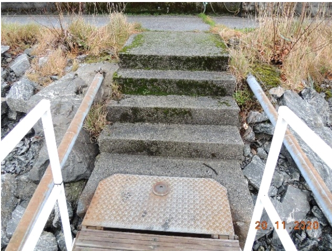
Trapp til flytebryggeanlegg.
