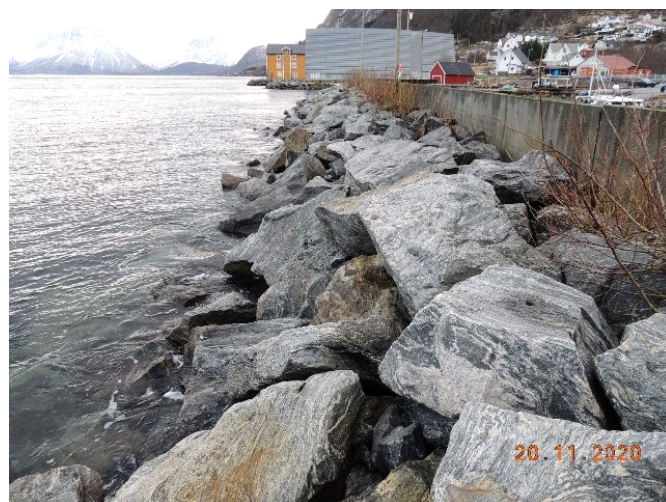
Utside av molo, i retning mot sør.
